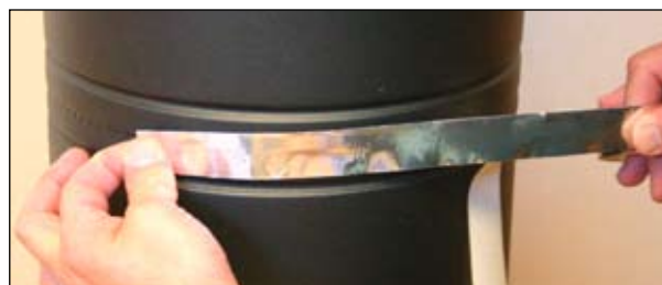
För att underlätta vid montering av skorstensmoduler kan modulen delas något. På så sätt får man en bättre överblick när skorstensmodulerna skall sättas samman.
