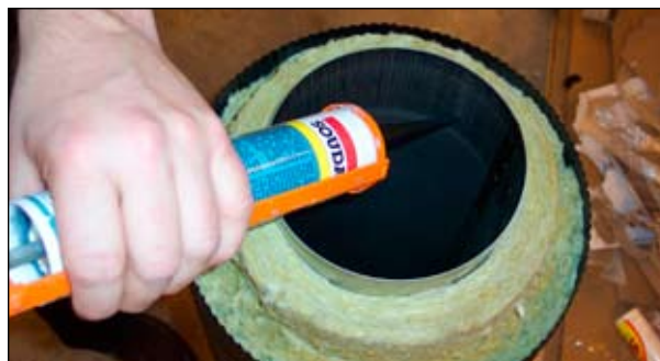
Brandkitt appliceras invändigt i skorstensens innerrör (hondelen).
